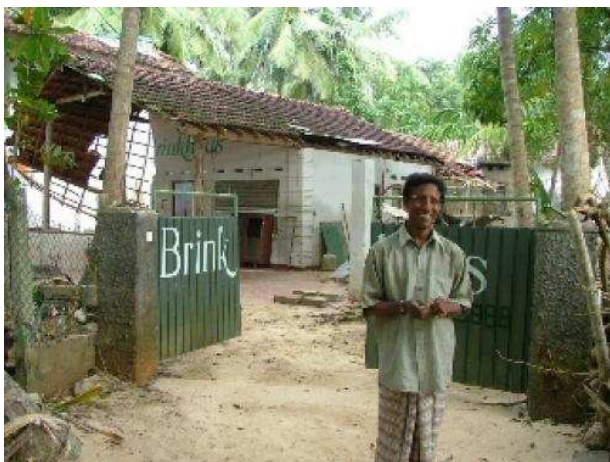
Eine Sri Lanki zeigt sein zerstörtes Haus
